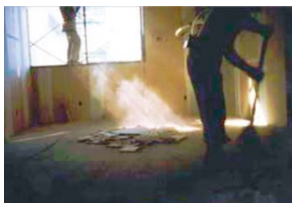
＜清掃・片付け作業＞
