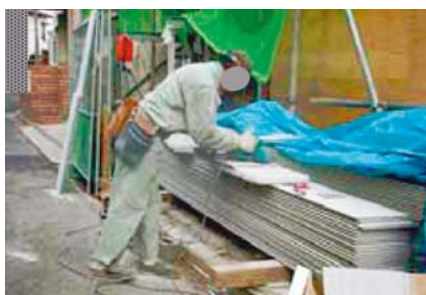
＜サイディング切断作業＞
