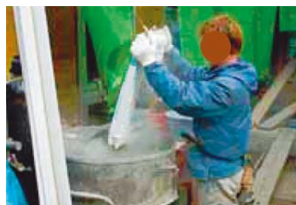
＜モルタル混和作業・左官工など＞
