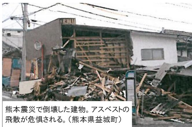
熊本震災で倒壊した建物。アスベストの飛散が危惧される。(熊本県益城町)
